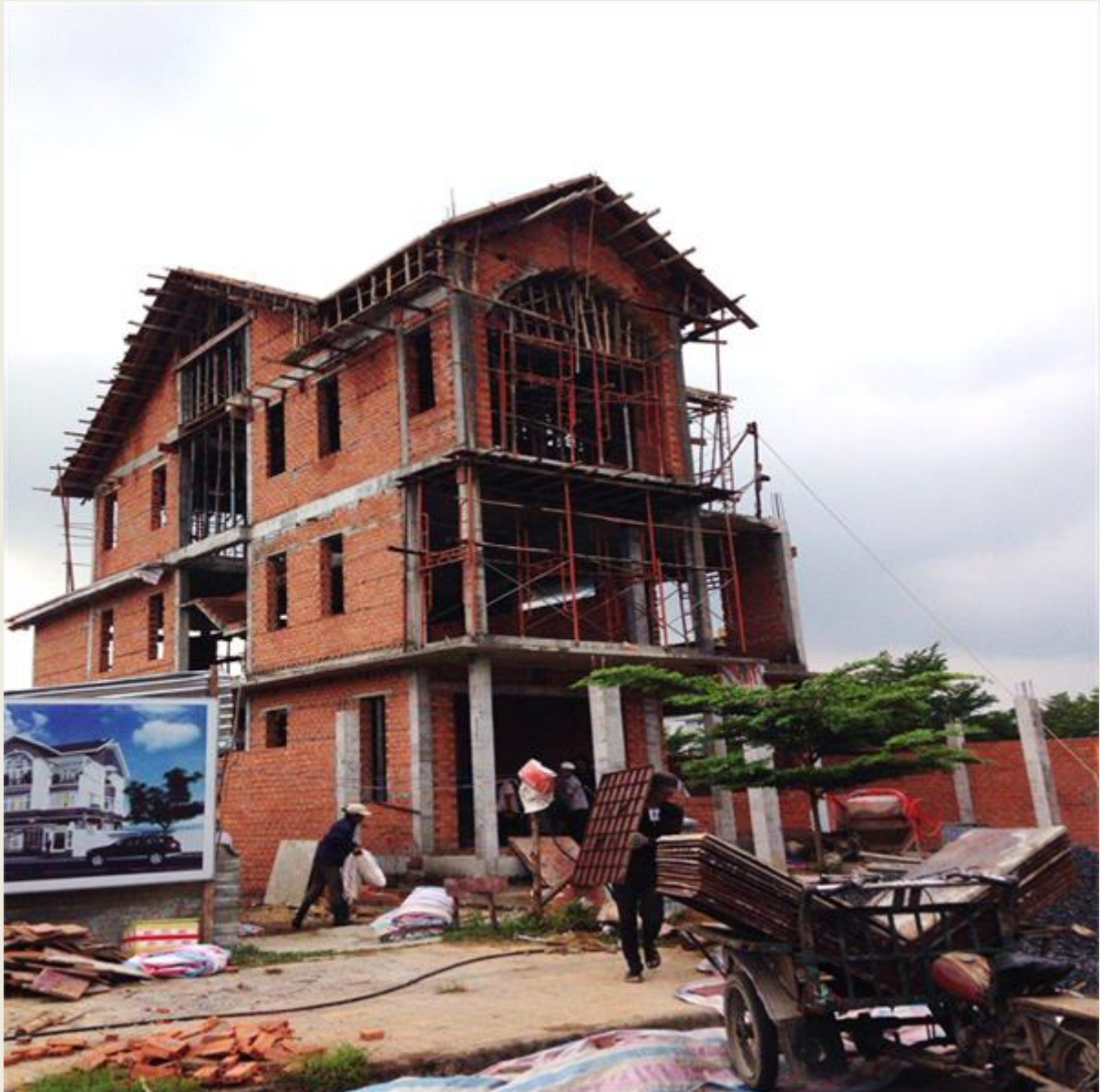
Hình ảnh khi thi công được công ty HAC-HOME.vn chụp hình gửi cho khách hàng sau mỗi công đoạn nghiệm thu
