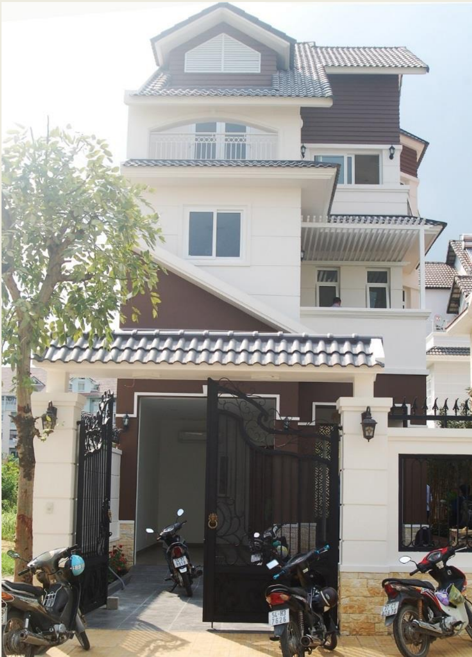
Ngôi nhà sau khi thi công hoàn thiện với thiết kế kiến trúc đẹp mắt
