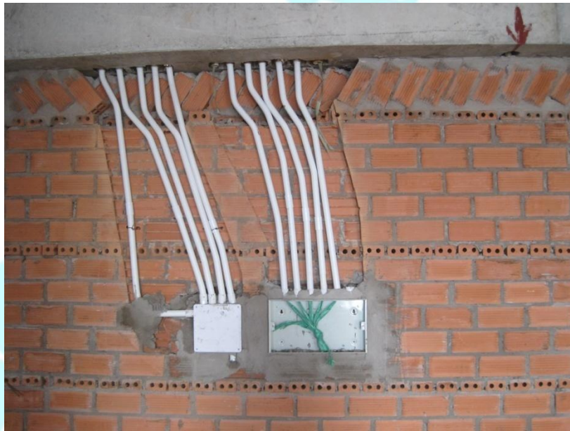
VỊ TRÍ HỆ THỐNG ĐIỆN ÂM TƯỜNG
