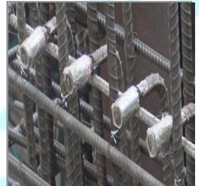
Nối thép bằng coupler
