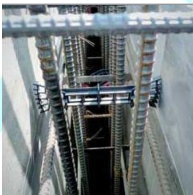
Lắp đặt kê nhựa
