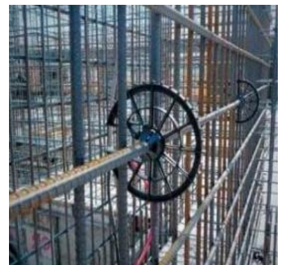
Lắp đặt kê nhựa
