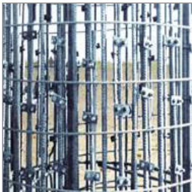
Nối thép bằng Ubolt
